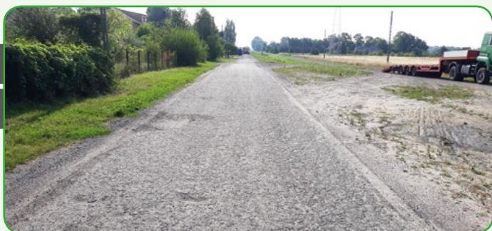
Droga przed remontem
